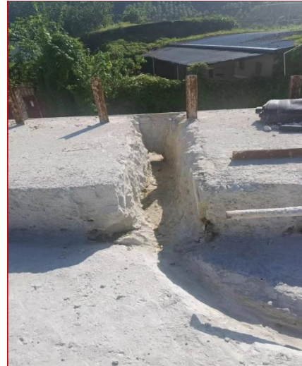
(b) 施工过程中预留排水通道
